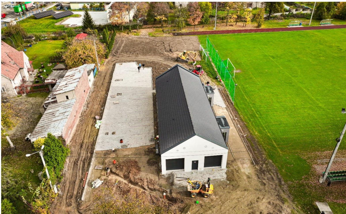
Budowa szatni sportowej w Marcinowicach w ramach zadania: „Budowa i modernizacja budynków użyteczności publicznej na terenie Gminy Marcinowice”- Polski Ład Edycja II.
