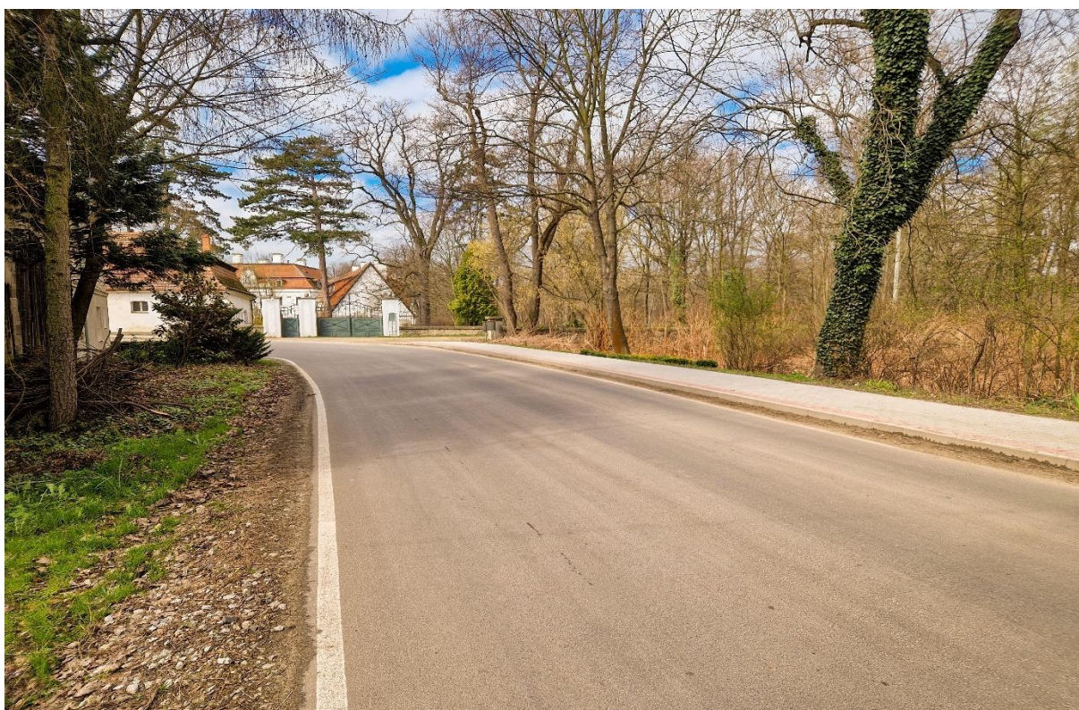
Budowa chodnika w Kraskowie w ramach zadania „Budowa chodników na terenie Gminy Marcinowice” - Polski Ład III PGR.
