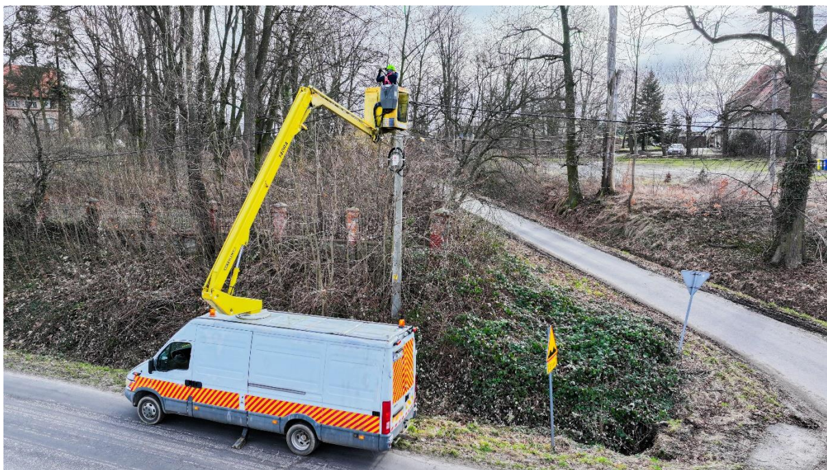
Modernizacja systemu oświetlenia ulicznego na terenie Gminy Marcinowice.
