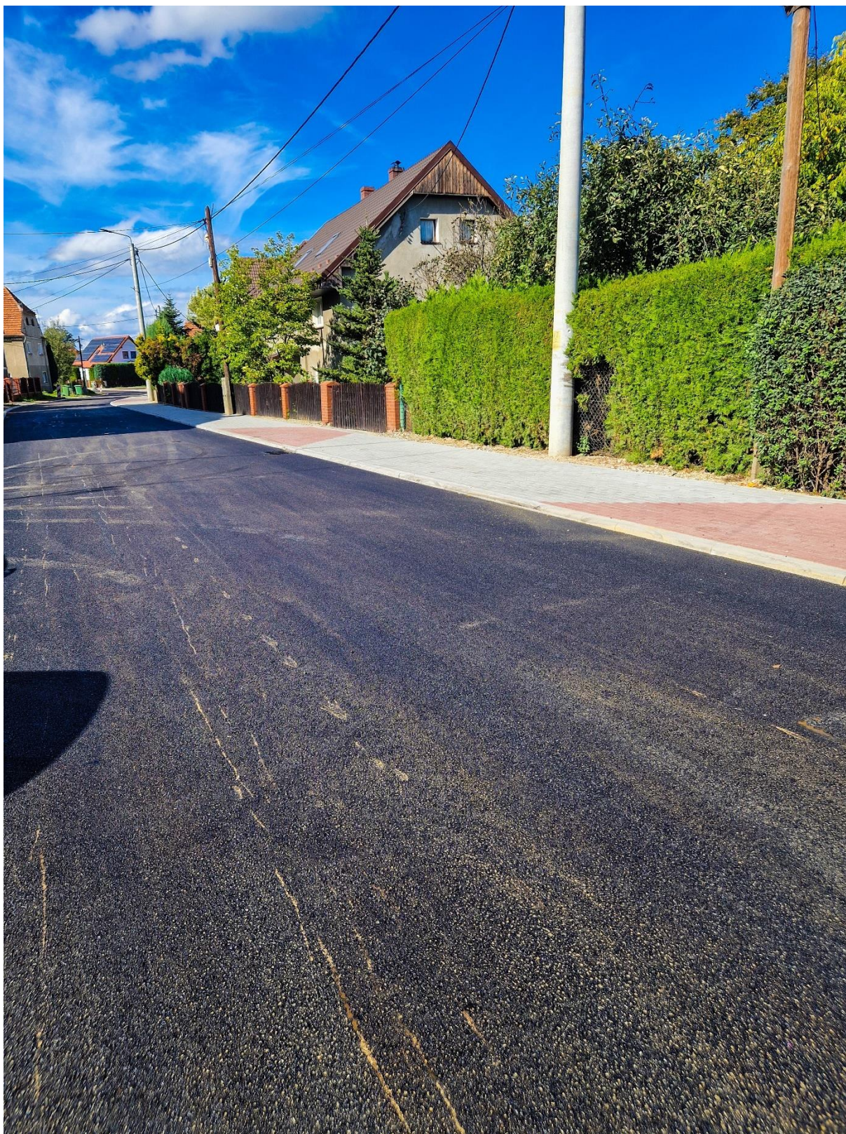
Marcinowice ul. Kwiatowa w ramach zadania „Budowa i modernizacja dróg na terenie Gminy Marcinowice - Polski Ład Edycja 8”.
