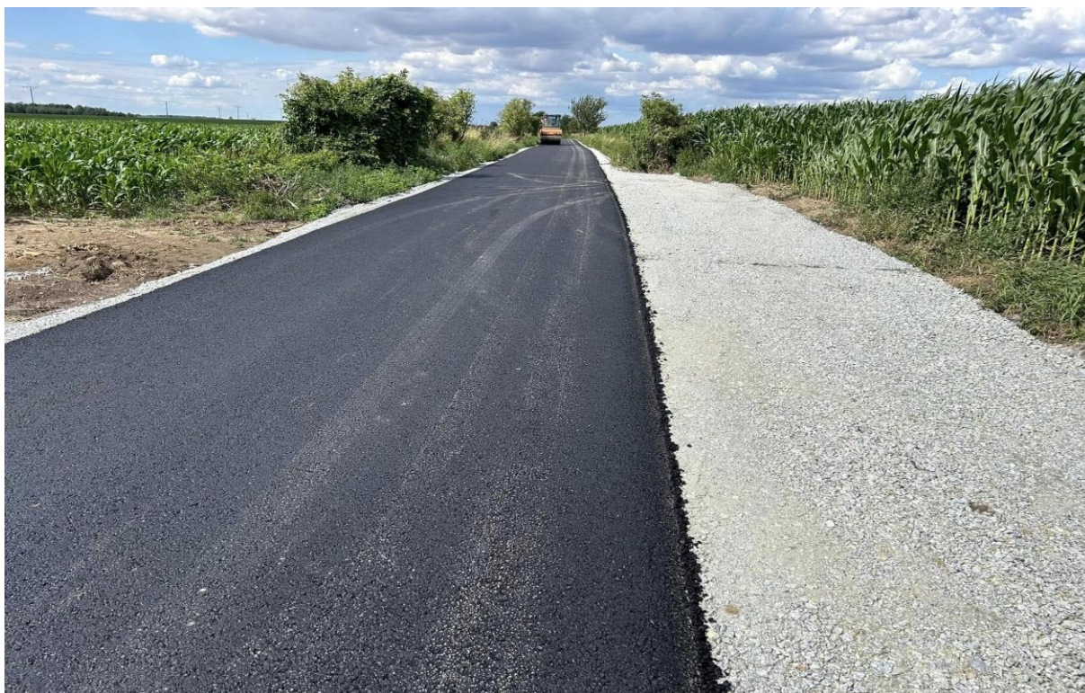
Droga transportu rolnego Biała – Chwałków w ramach zadania „Budowa i modernizacja dróg na terenie Gminy Marcinowice - Polski Ład Edycja 8” oraz „Biała – Chwałków droga transportu rolnego”.
