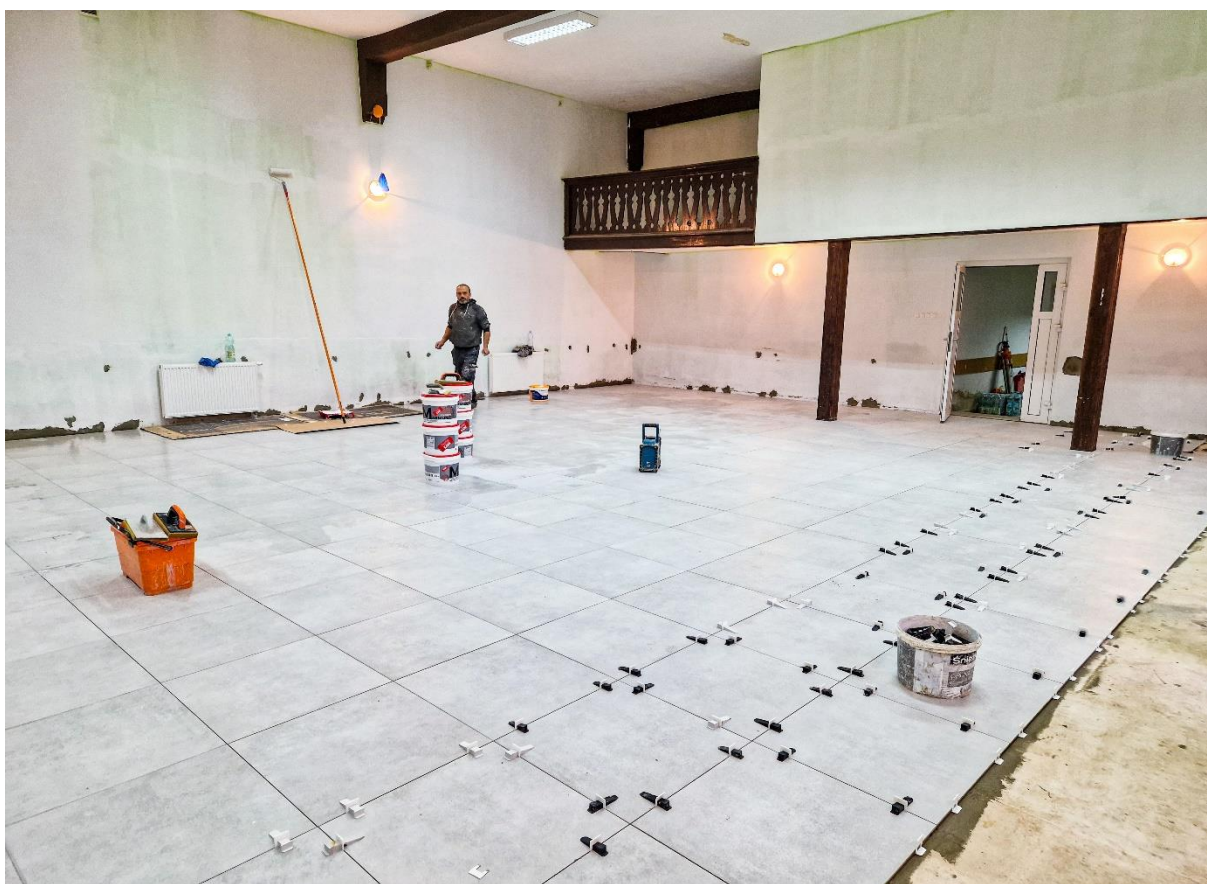
Wykonanie podłogi w świetlicy wiejskiej w Sadach.
