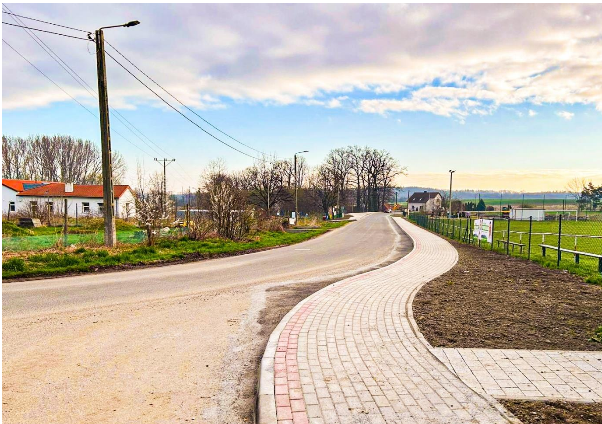
Budowa chodnika w Kątkach w ramach zadania „Budowa chodników na terenie Gminy Marcinowice” - Polski Ład III PGR.
