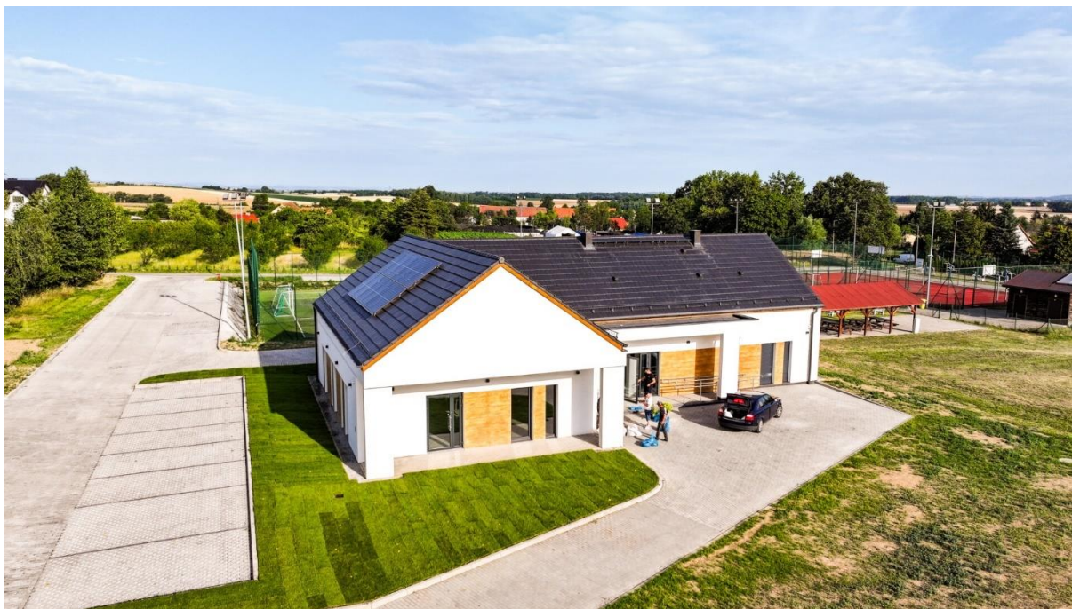
Budowa Centrum Sportu w Wirkach w ramach zadania: „Budowa i modernizacja budynków użyteczności publicznej na terenie Gminy Marcinowice”- Polski Ład Edycja II.
