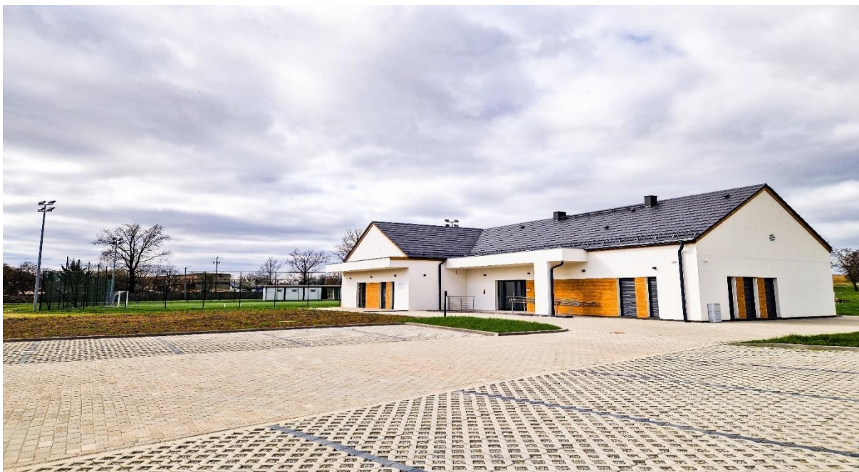
Budowa Centrum Sportu i Rekreacji w Szczepanowie w ramach zadania: „Budowa i modernizacja budynków użyteczności publicznej na terenie Gminy Marcinowice”- Polski Ład Edycja II.
