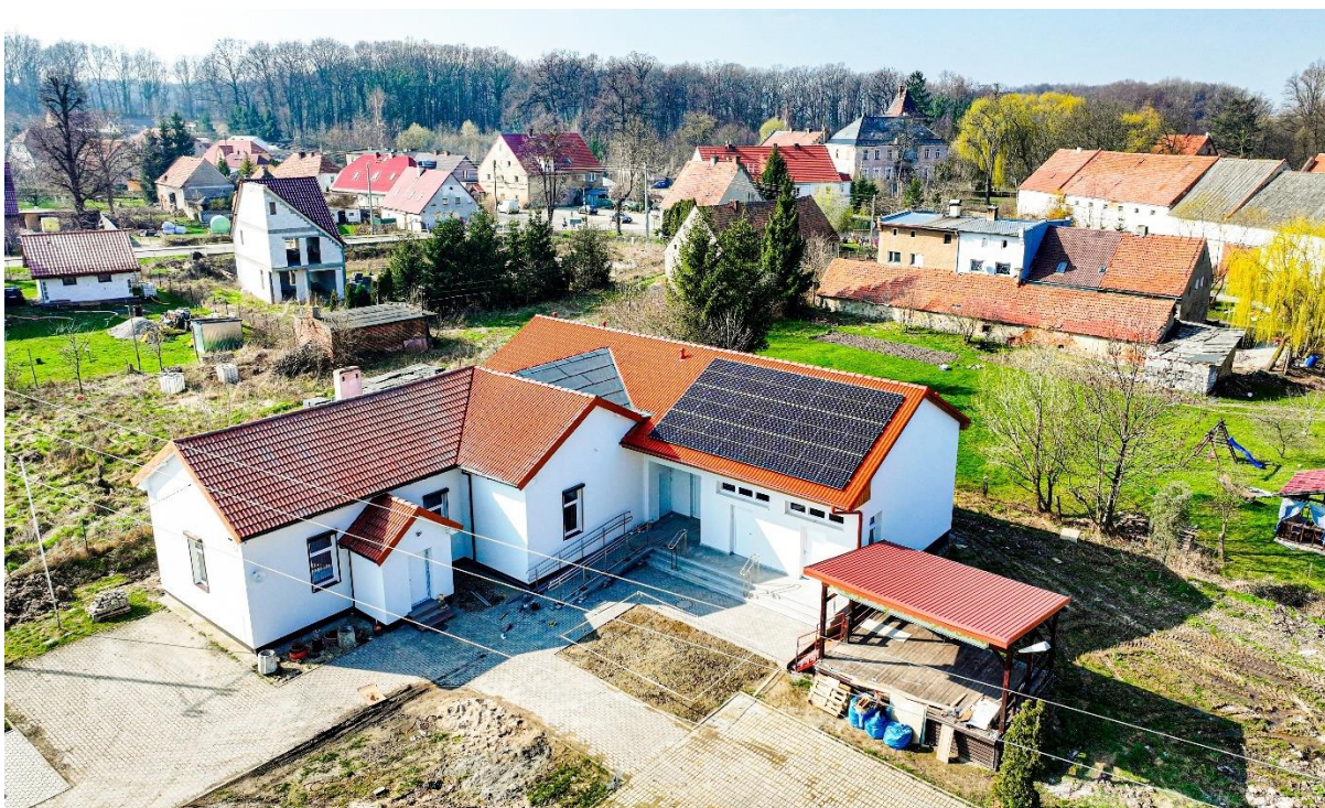
Rozbudowa świetlicy wiejskiej w Kątkach w ramach zadania: „Budowa i modernizacja budynków użyteczności publicznej na terenie Gminy Marcinowice”- Polski Ład Edycja II.
