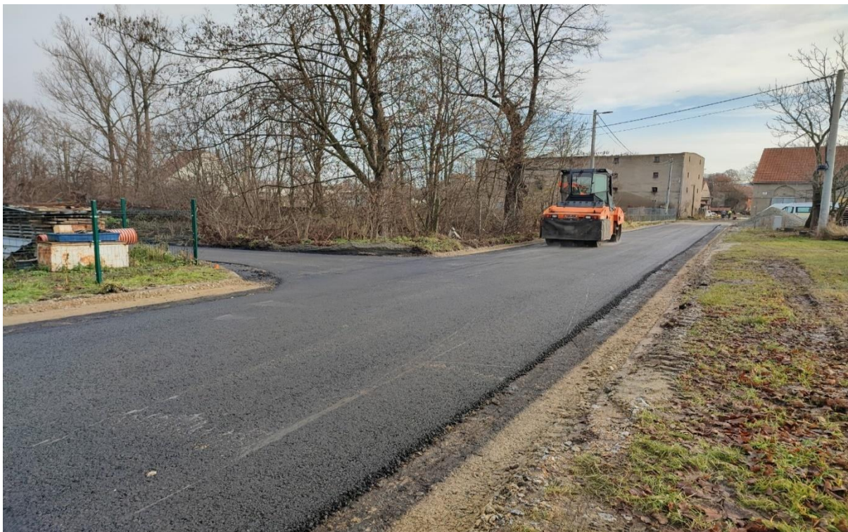
Przebudowa dróg osiedlowych po byłym PGR w Szczepanowie
