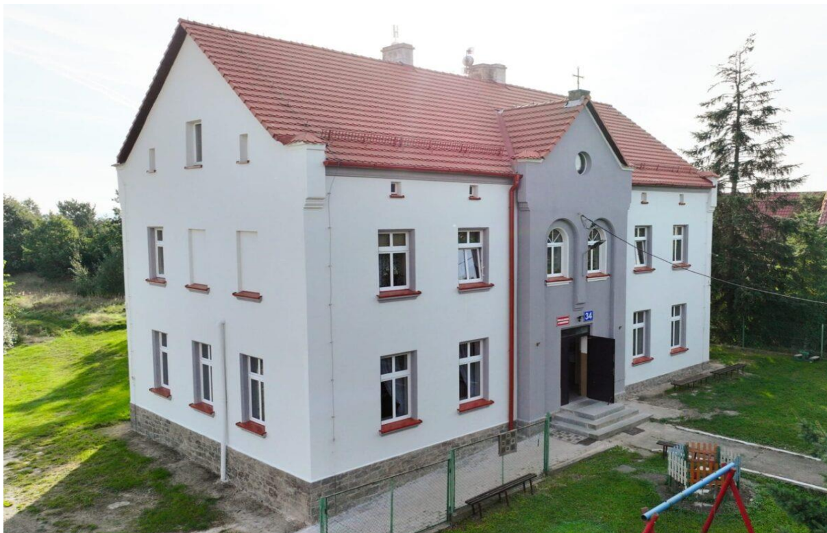
Wykonanie elewacji budynku świetlicy wiejskiej w Śmiałowicach
