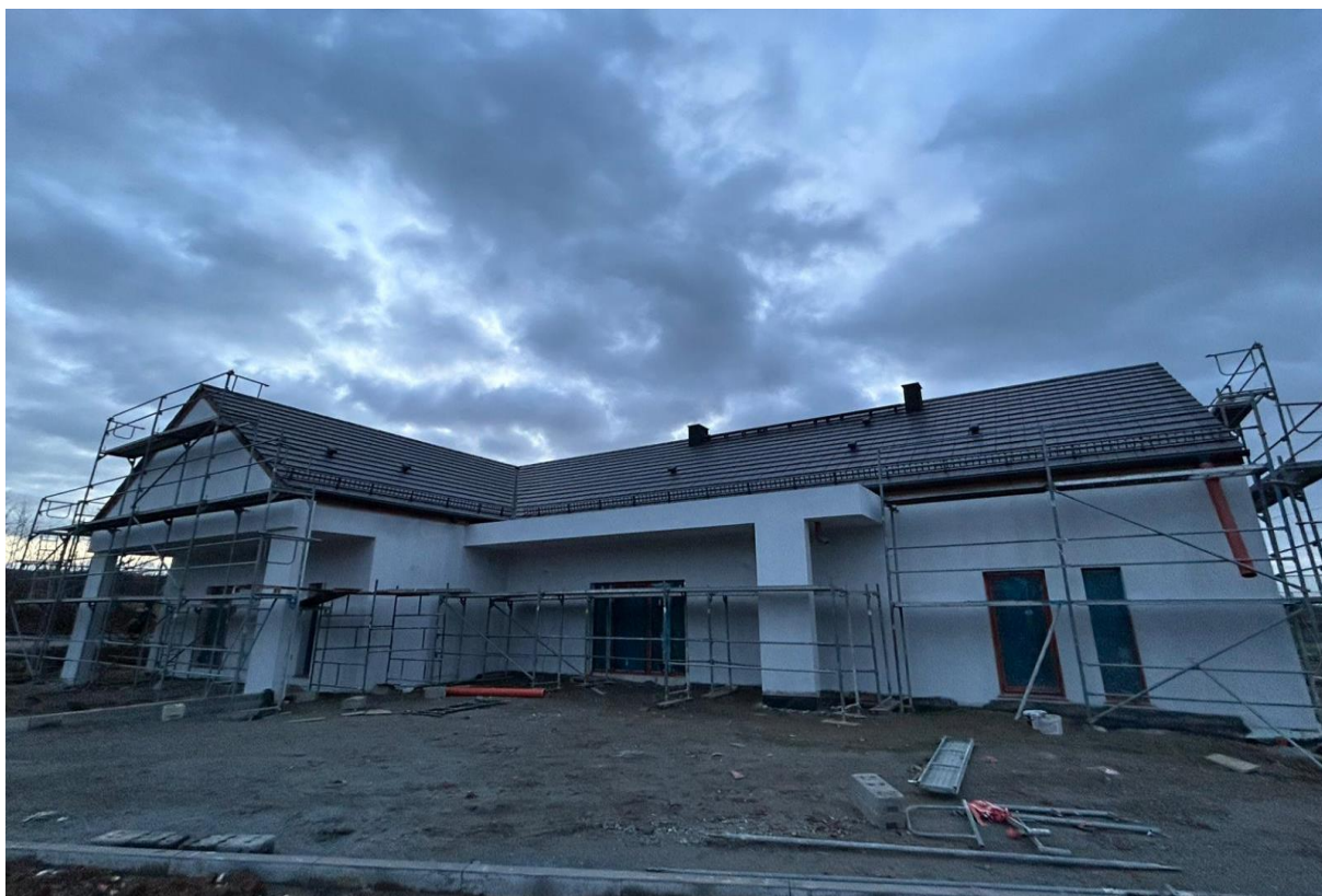
Budowa świetlicy wiejskiej w Wirkach
