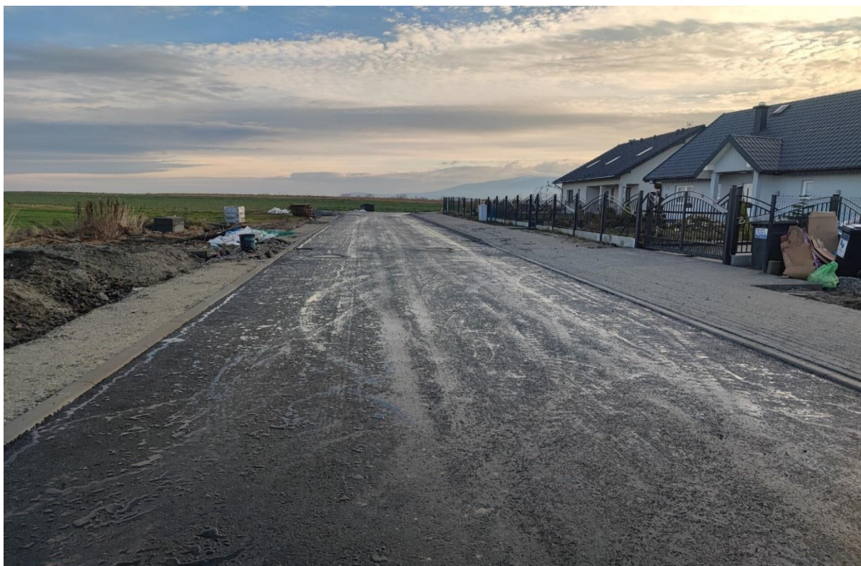
Przebudowa dróg osiedlowych w Marcinowicach ul. M. Konopnickiej
