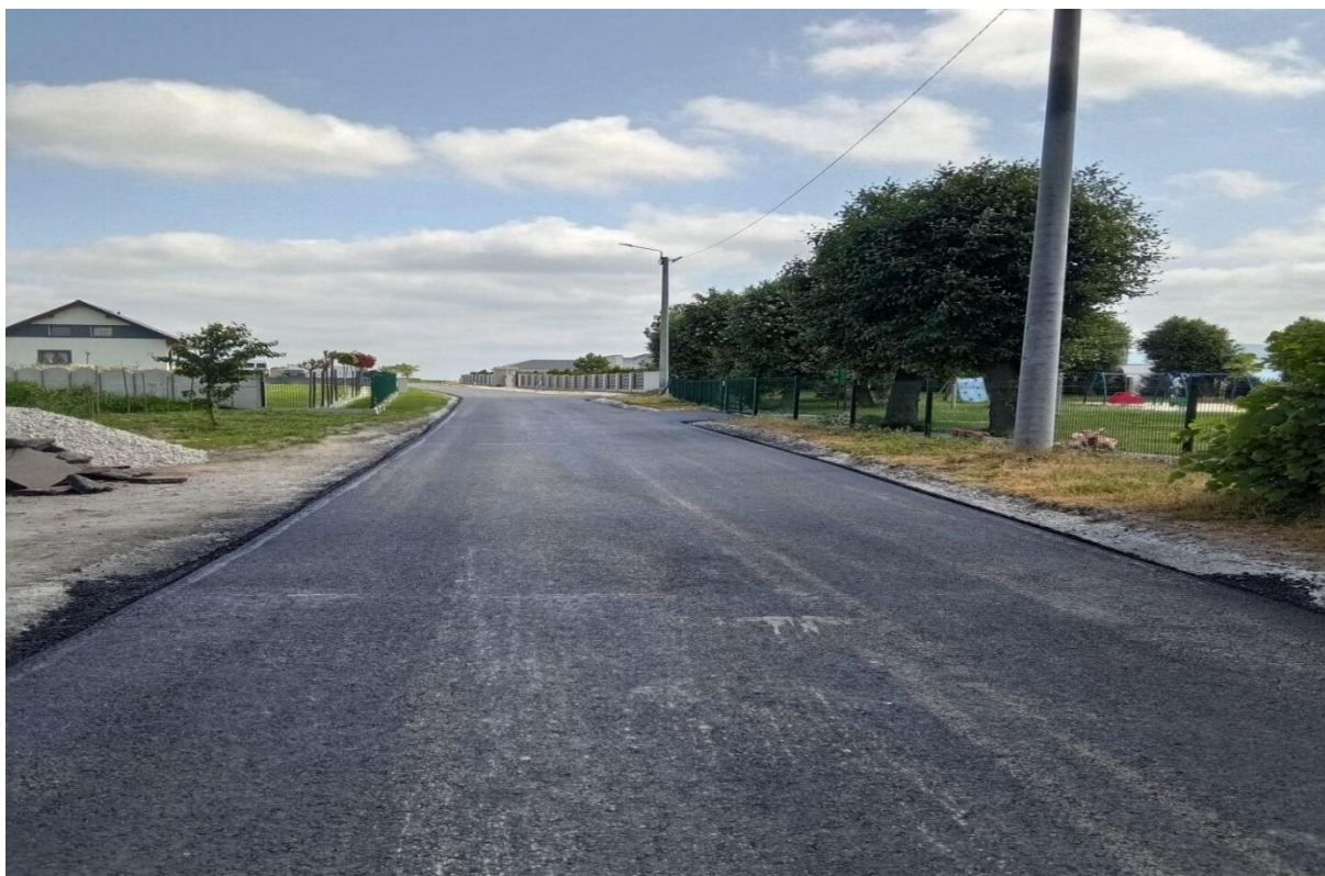
Przebudowa drogi gruntowej w Goli Świdnickiej
