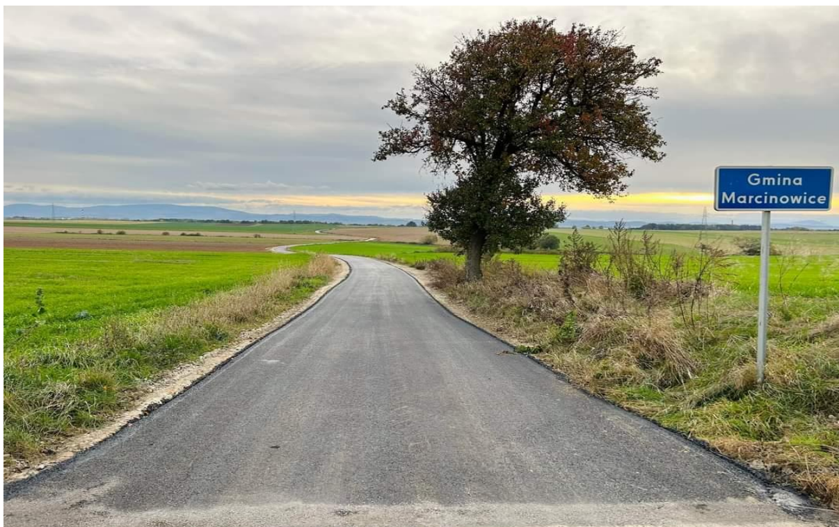
Droga dojazdowa do gruntów rolnych w Śmiałowicach dz. nr 142
