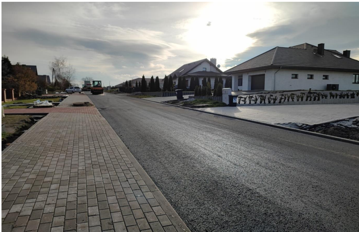
Przebudowa dróg osiedlowych w Marcinowicach ul. T. Gajcego
