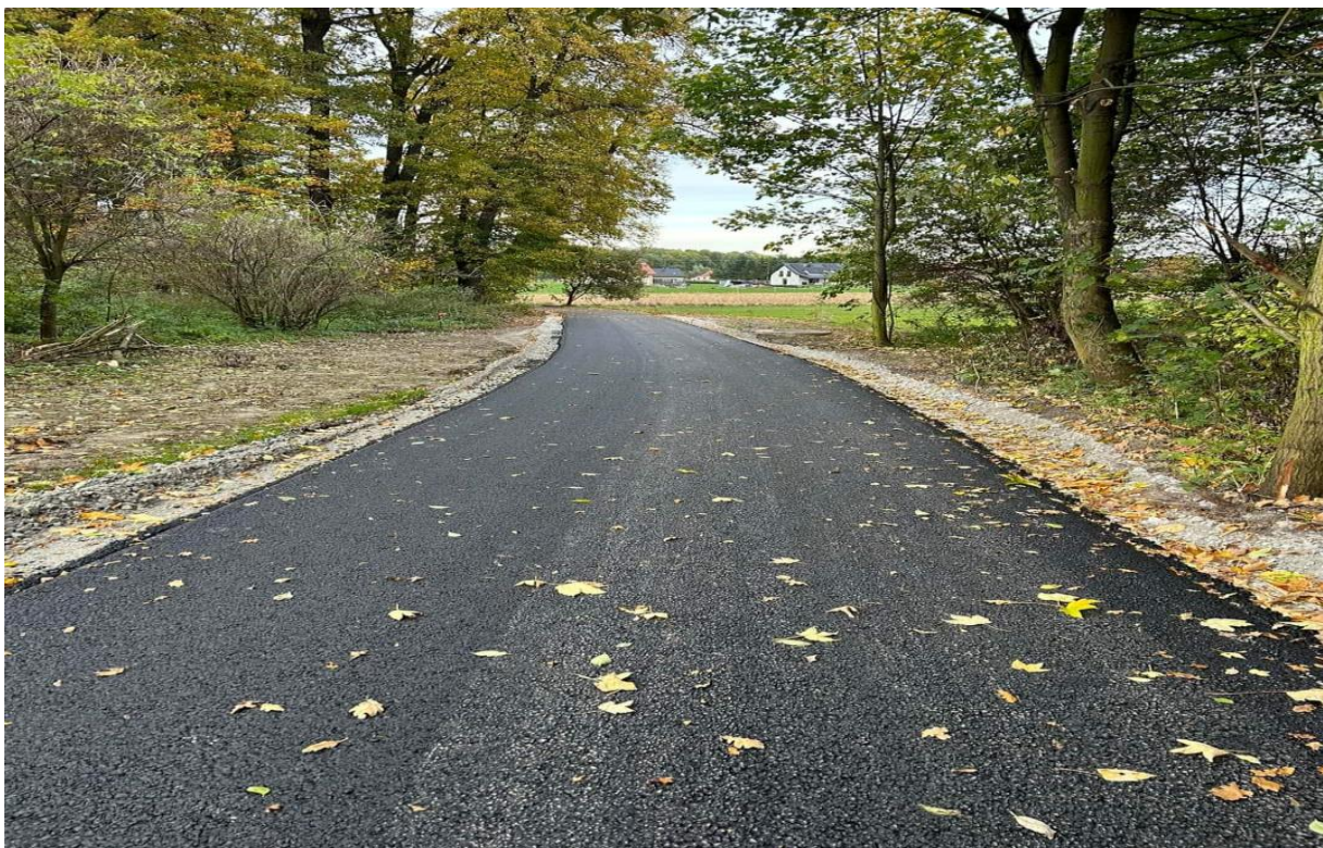
Droga dojazdowa do gruntów rolnych w Gruszowie dz. nr 88
