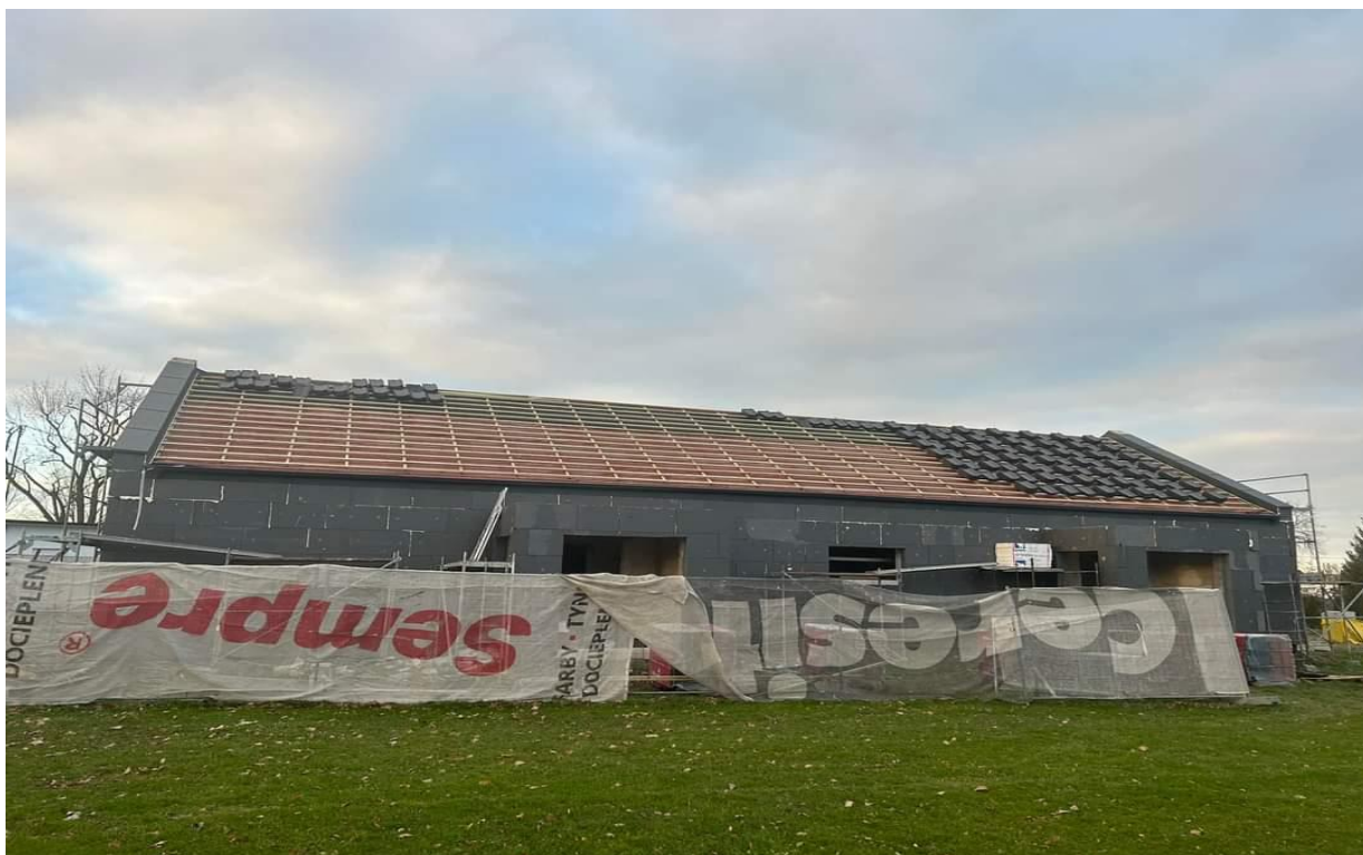
Budowa szatni sportowej na boisku w Marcinowicach
