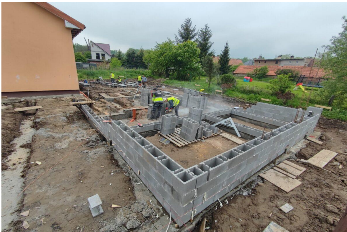
Rozbudowa świetlicy wiejskiej w Kątkach
