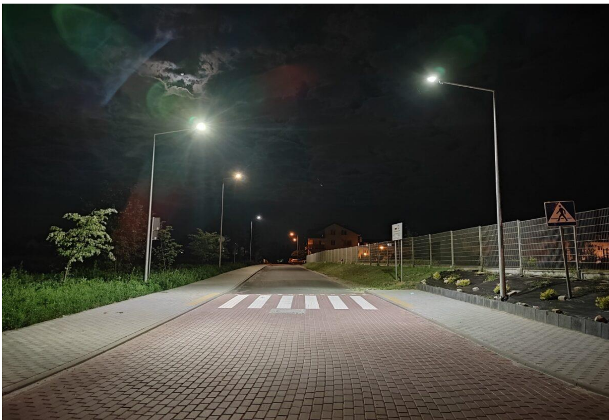
Modernizacja systemu oświetlenia ulicznego na terenie Gminy Marcinowice
