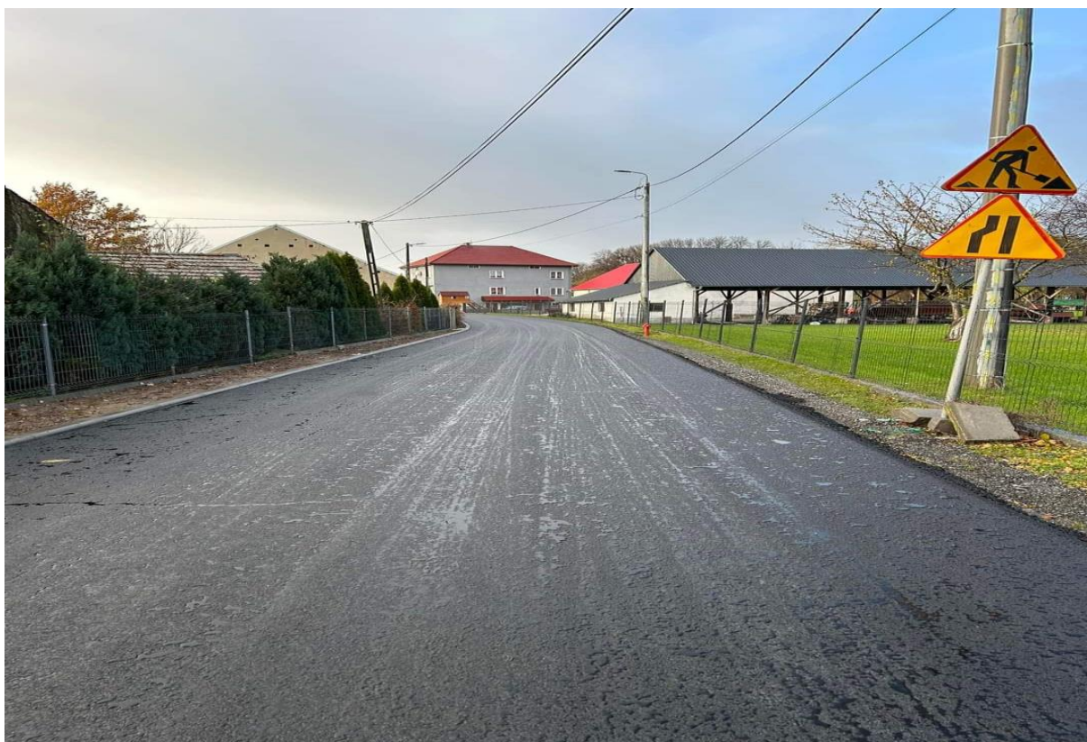
Przebudowa drogi gminnej w Tworzyjanowie
