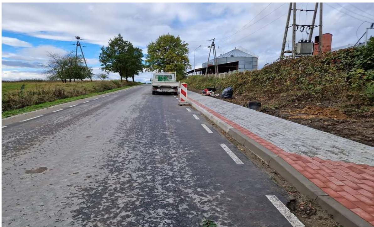
Budowa ogólnodostępnych chodników w Śmiałowicach
