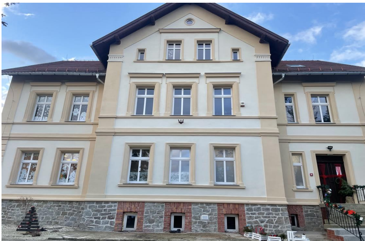
Remont elewacji budynku nr 61 w Wirach
