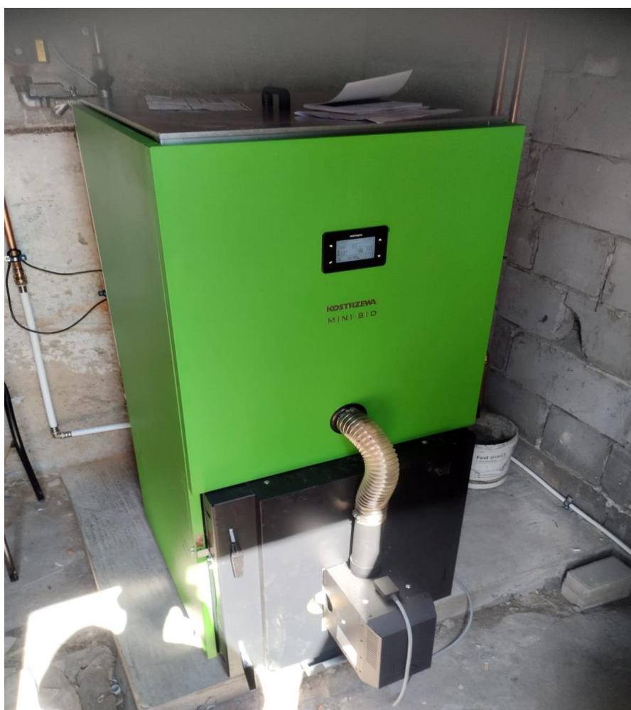
Wymiana pieca na świetlicy wiejskiej w Sadach
