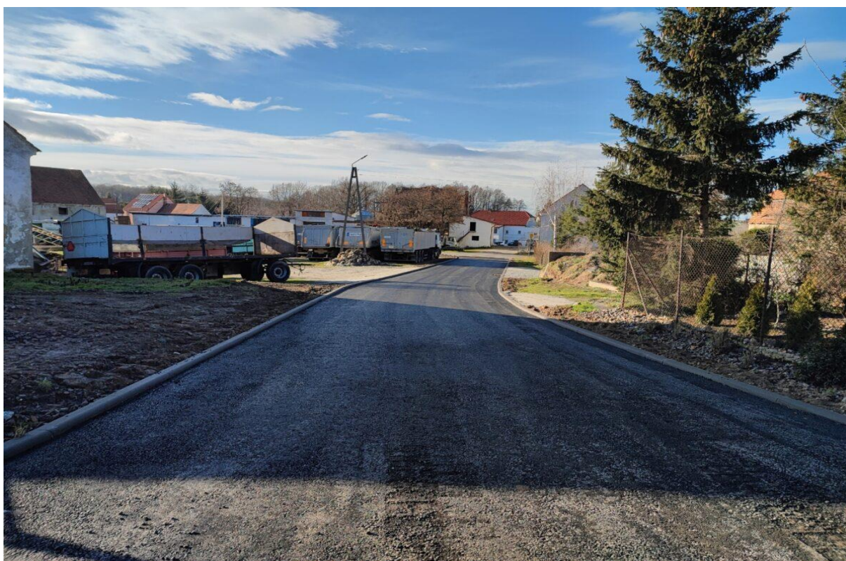
Przebudowa drogi gruntowej w Klecinie
