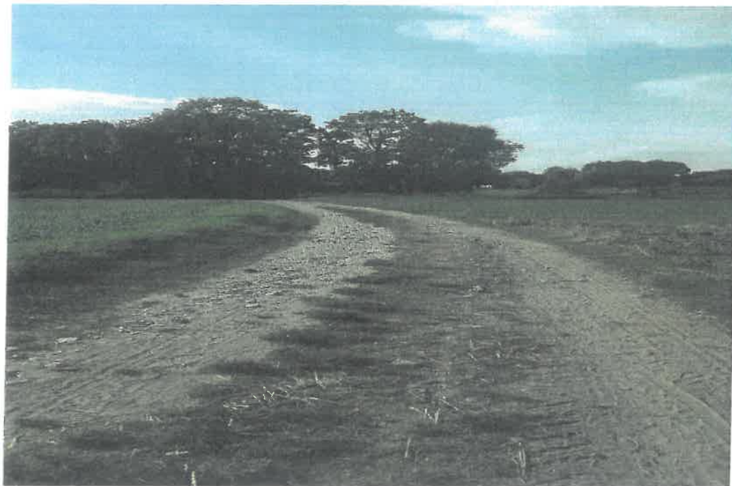
zdj.1,2 Istniejąca nawierzchnia gruntowo tłuczniowa
