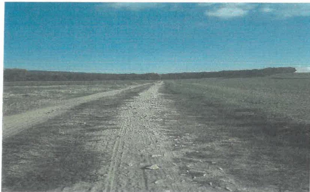
zdj.1,2 Istniejąca nawierzchnia gruntowo tłuczniowa
