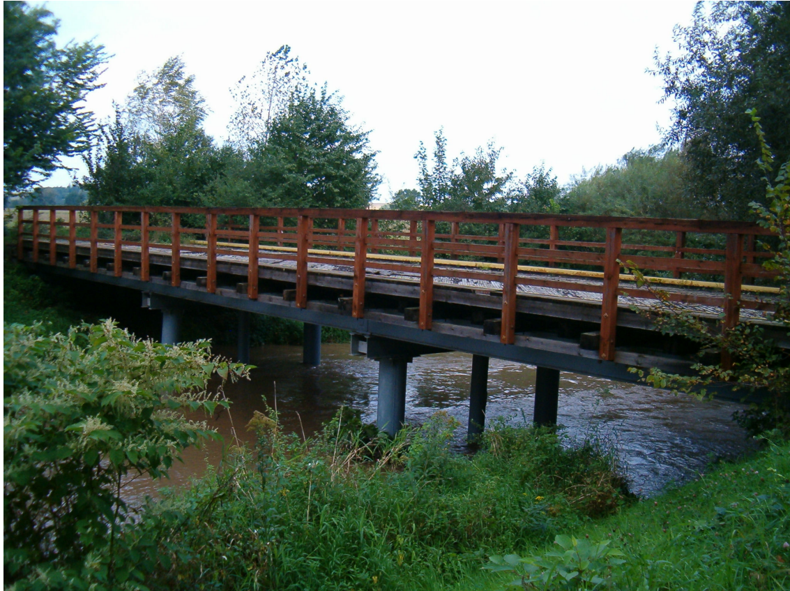
Z-1 Widok ogólny mostu od strony górnej wody.
