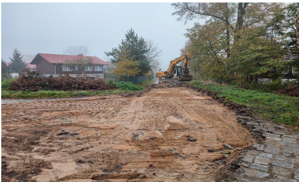
Przebudowa dróg do budynków mieszkalnych po byłym PGR w miejscowości Szczepanów
