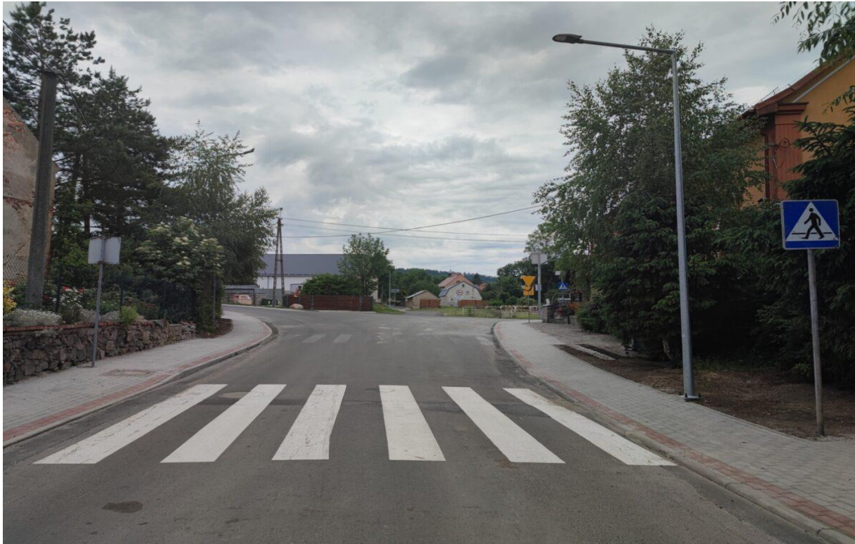
Budowa przejścia dla pieszych wraz z chodnikiem na drodze w Wirkach
