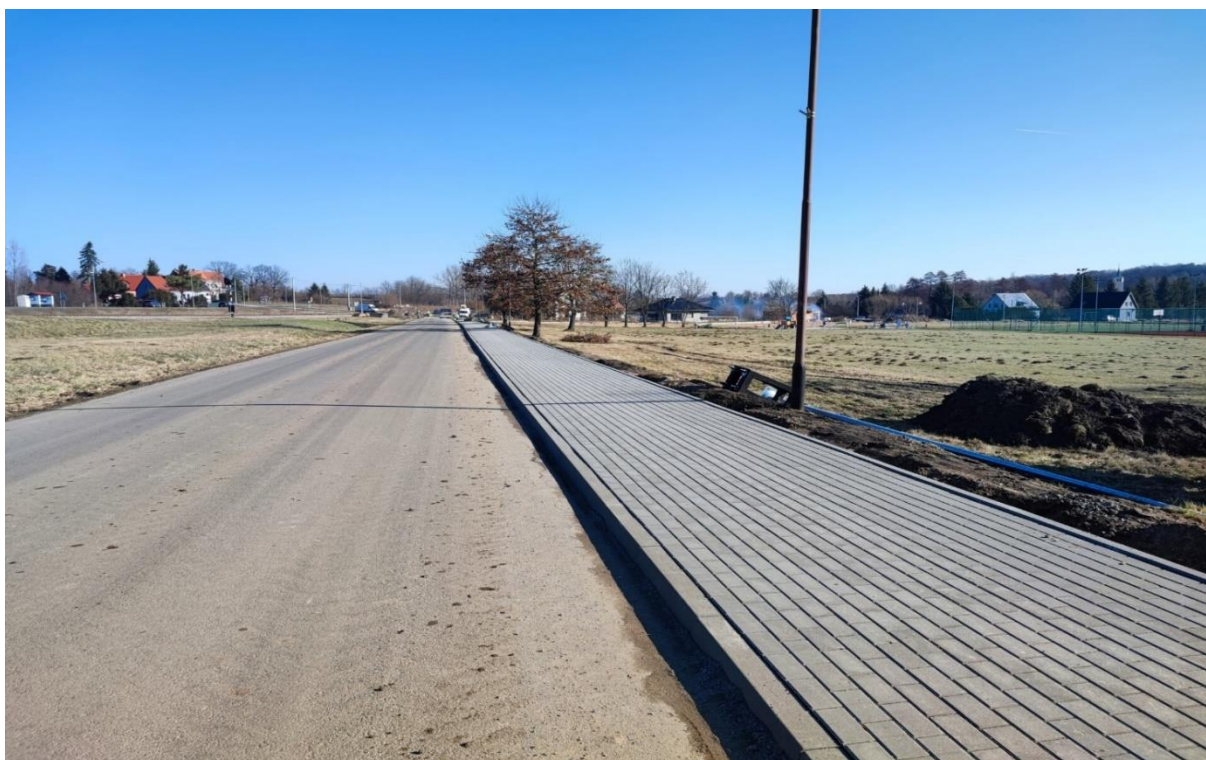
Bezpieczne przejście wraz z chodnikiem w miejscowości Szczepanów
