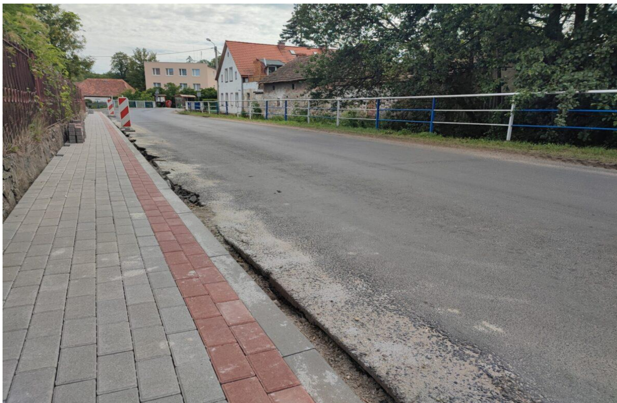
Budowa chodnika w miejscowości Chwałków
