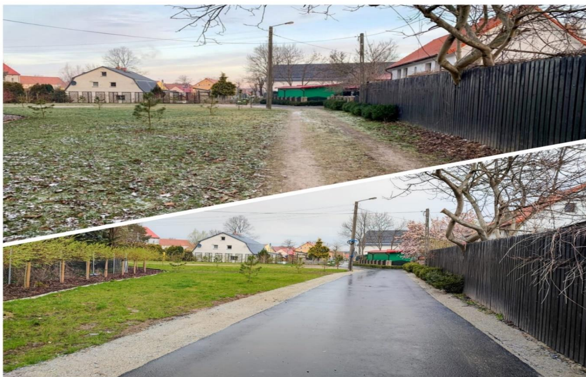
Przebudowa drogi gminnej w m. Wirki
