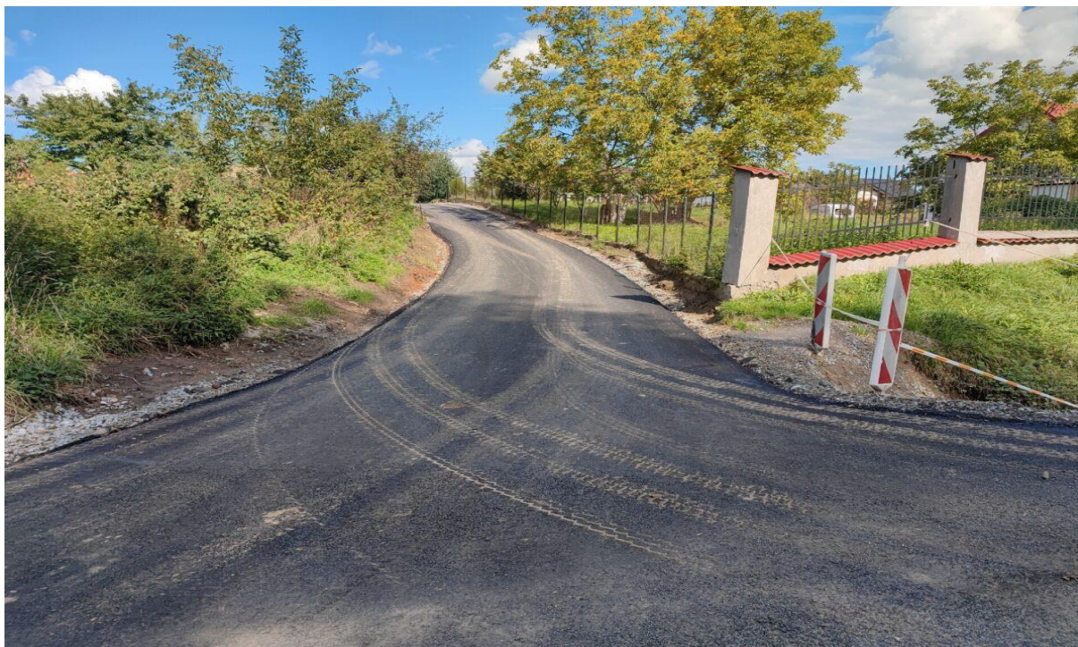
Przebudowa drogi wewnętrznej w miejscowości Zebrzydów
