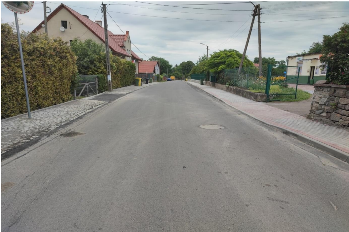
Budowa przejścia dla pieszych wraz z chodnikiem na drodze w Wirkach
