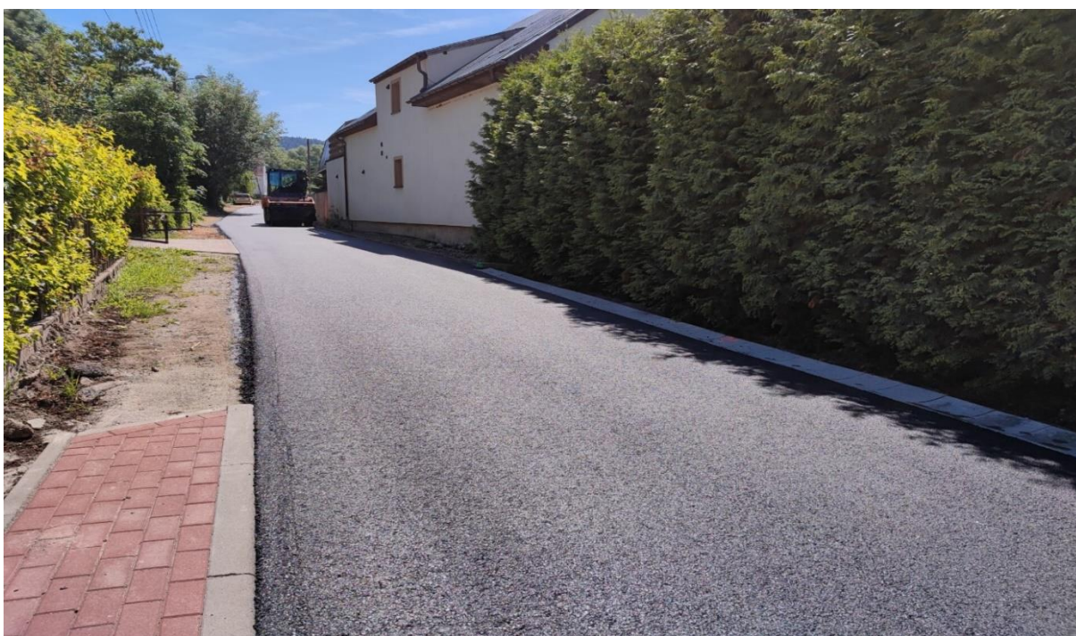
Remont drogi gminnej w m. Tąpadła
