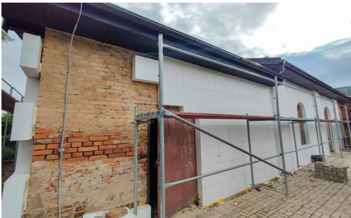
Wykonanie elewacji wraz z ociepleniem budynku świetlicy wiejskiej w m. Sady
