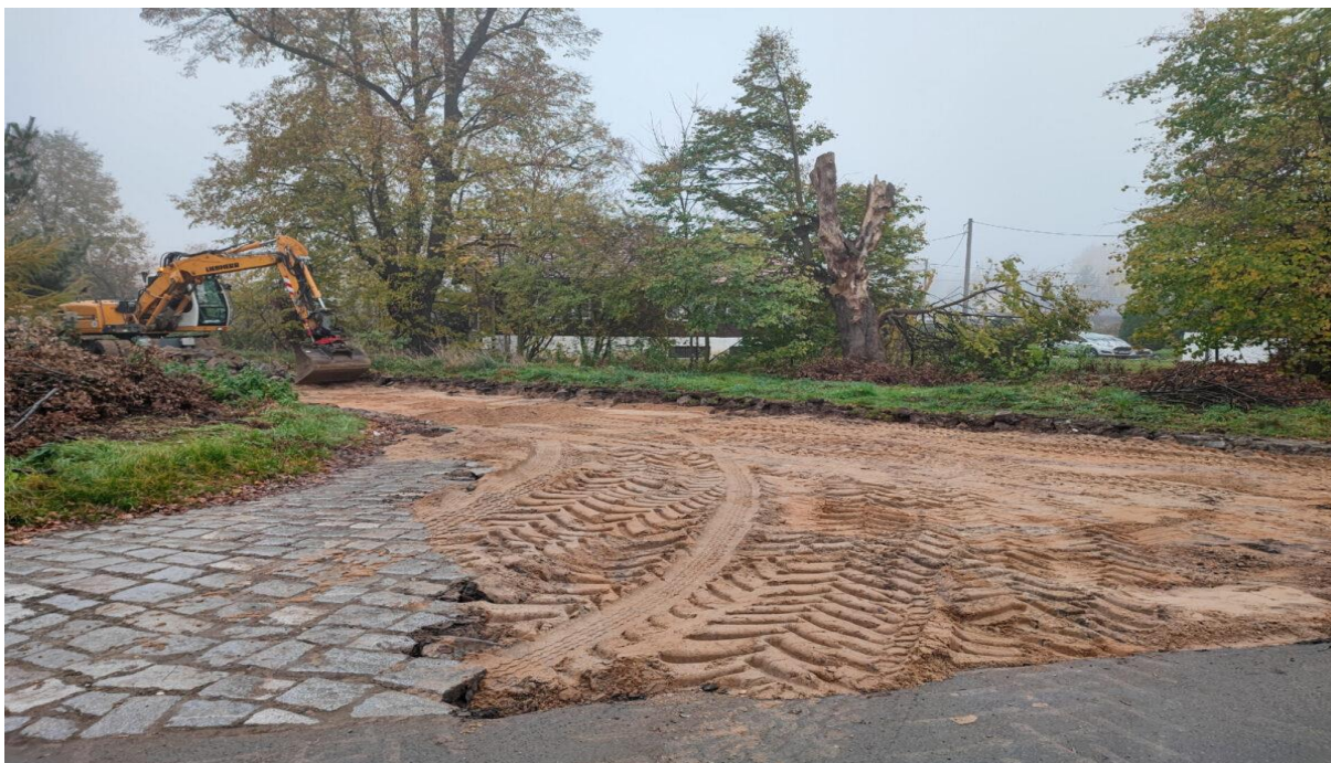
Przebudowa dróg do budynków mieszkalnych po byłym PGR w miejscowości Szczepanów
