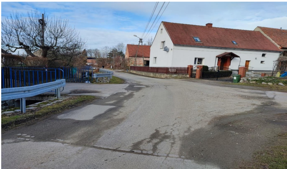
Remont drogi gminnej w m. Tąpadła
