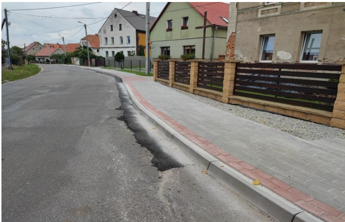
Budowa ogólnodostępnych chodników w m. Biała
