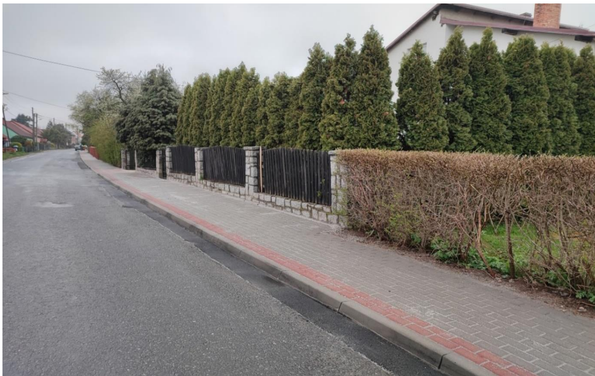
Przebudowa szlaku pieszego w miejscowości Sady
