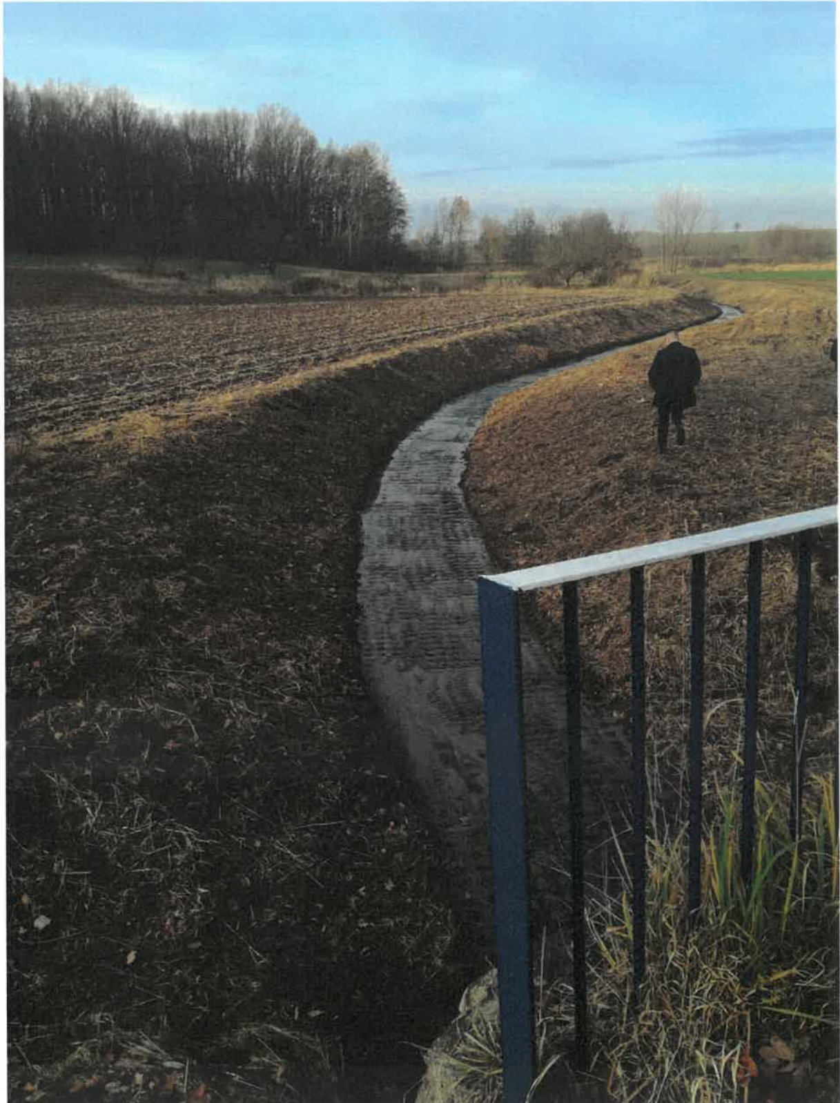
Potok Wieprzówka obręb Mysłaków
