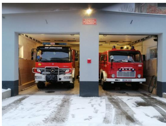
Remont remizy OSP Zebrzydów
