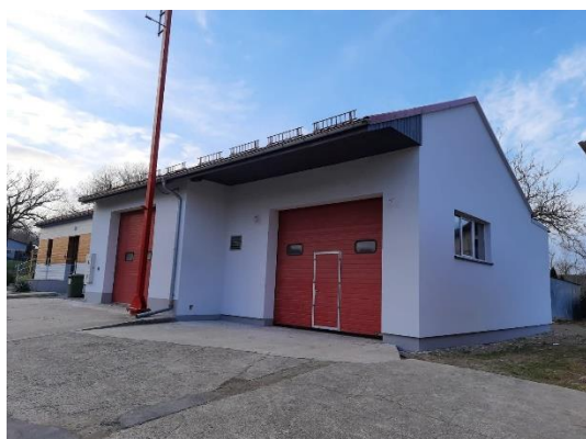
Remont remizy OSP w Tworzyjanowie.
