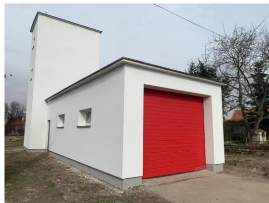
Remont remizy OSP Mysłaków
